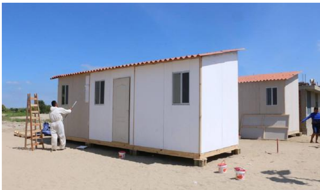
Figura 05. Instalación de Módulos temporales de vivienda para damnificados por El Niño
