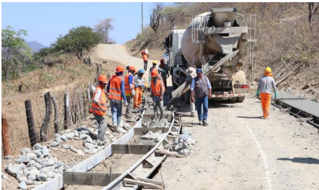
Figura 06. Reconstrucción de carreteras por El Niño Costero
